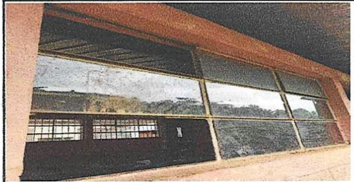
FOTO 10 CAMBIO DE VENTANAS
